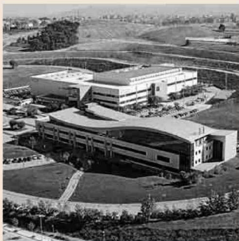
Instalaciones de Boehringer en Sant Cugat del Vallès.
