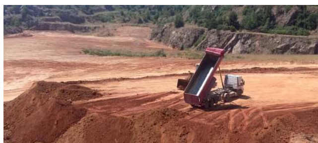
Treballs de restauració del turó de Montcada
