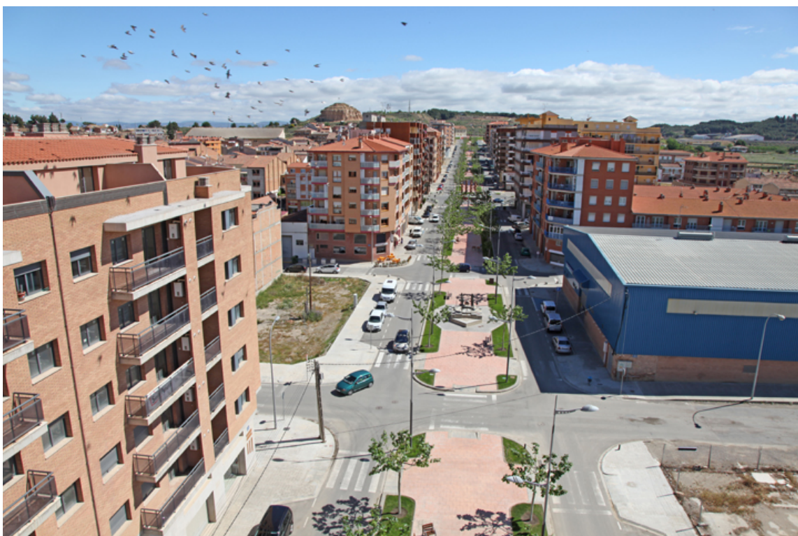
Les Rambles, més d'1 Km de passeig ininterromput i centre neuràlgic de la nova Almacelles
