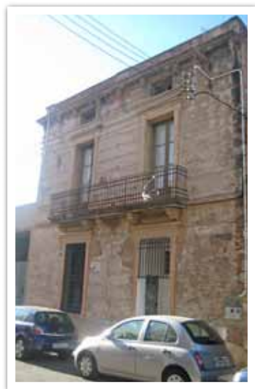
57 ► 2011, antic casal de la Fàbrica Seydoux (abans Vapor)
