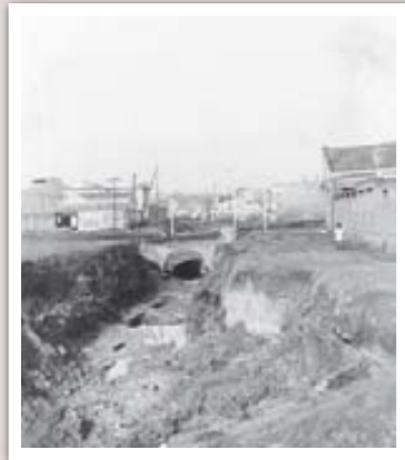
16 ► 1958, urbanització de la Riereta, actualment el lloc és la rambla d'Ibèria
