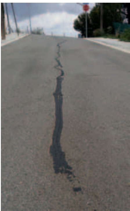
Una de les esquerdes apareguda al paviment de Can Coral
