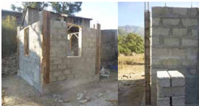
Prototip de bloc de formigó, vivenda mínima de Santamaia Didi, cuidadora de l'orfenat de Balmandir.
