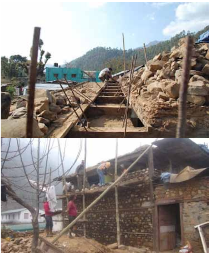
Prototip de reforç, de pedra i fang. Vivenda reparada i reforçada de la família Pradhan.
