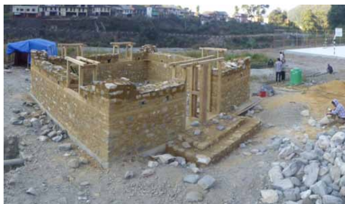
Prototip de pedra i fang, futur edifici de vestuaris i serveis per a la pista poliesportiva.
