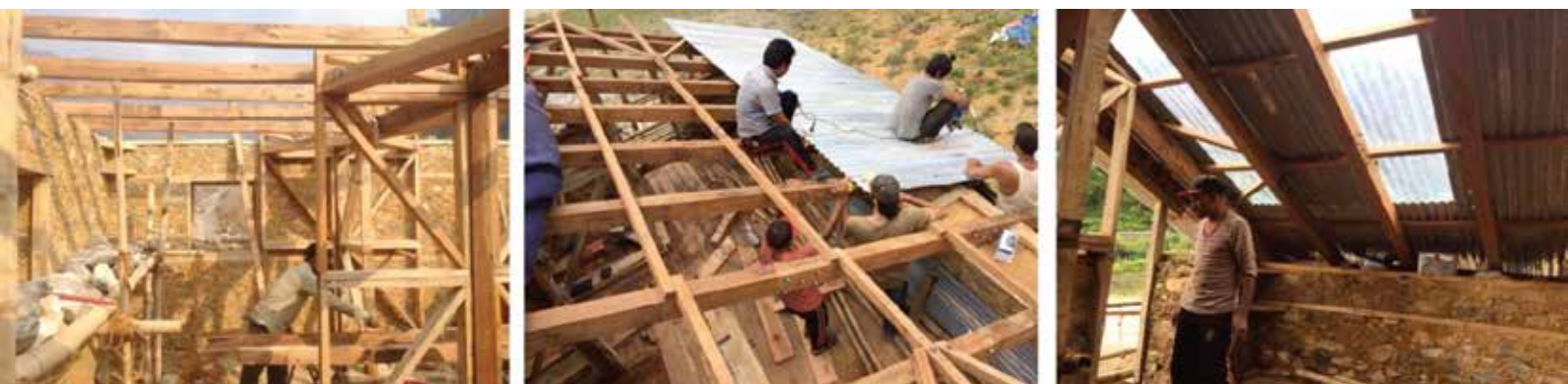
Procés de construcció del prototip de pedra i fang amb gran ús de fusta en la seva estructura interior.
