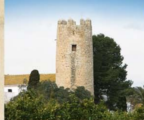
Torre de la Candela
