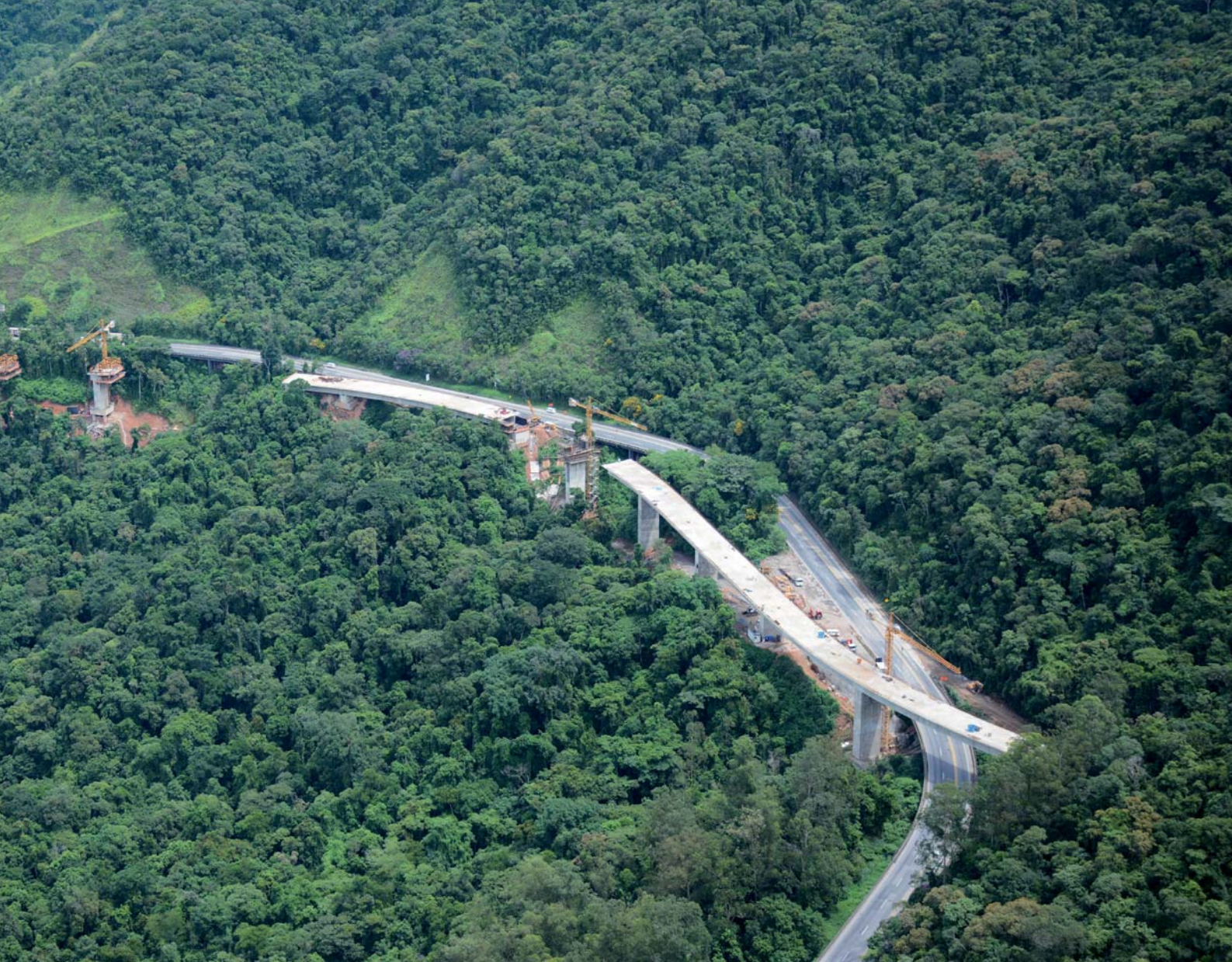
Vistas aérea de la serra do Cafezal.
