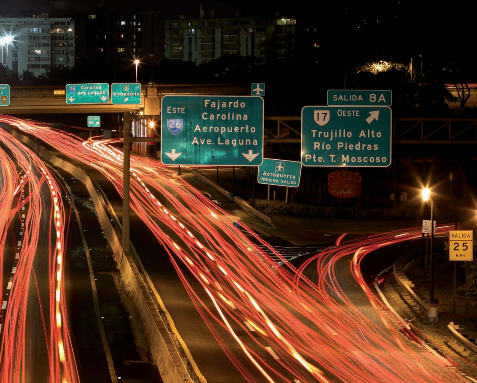
Uno de los proyectos más destacados es el Carril de Peaje Dinámico en la autopista PR-22.
