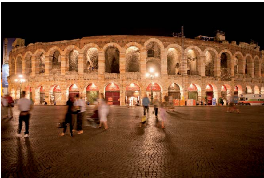
Panorámica de la Arena romana.
