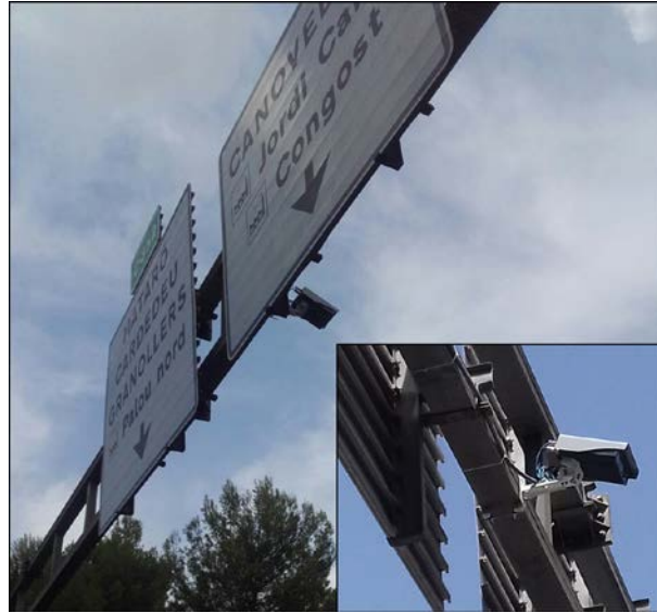
Fig 11. Càmera lectora de matrícules
