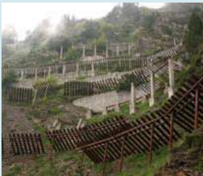
5. Mostrari de varietat de tipologies de barreres rígides de retenció del mantell en l'evolució històrica a Barèges, Pirineu francès.
