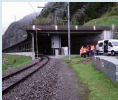
2. Galeria de coberta de protecció de la carretera i el ferrocarril de Gotthard a Andermatt, Alps suïssos.
