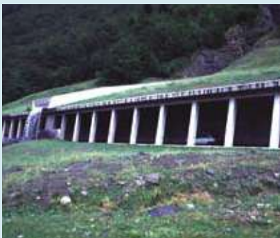
1. Galeria de coberta de la carretera D-934 del Col du Pourtalet, Pirineu francès.
