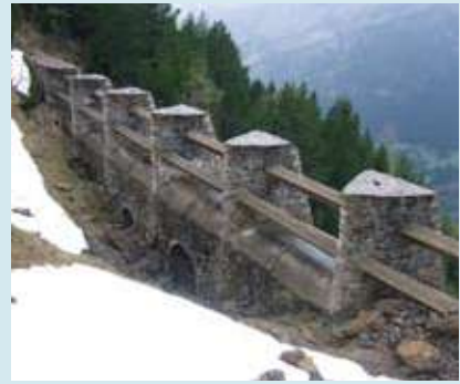
6. Dic de frenada de flux a mitja canal sobre Canfranc, Pirineu aragonès.
