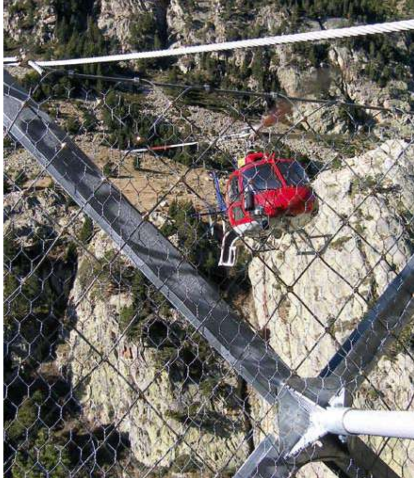
Instal·lació de barreres tipus umbrelli mitjançant helicòpter a la Vall de Núria, Pirineus catalans.
