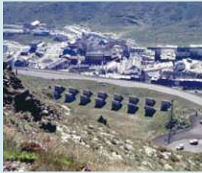
5. Dents de frenada en un replà sobre el Pas de la Casa, Pirineu andorrà.
