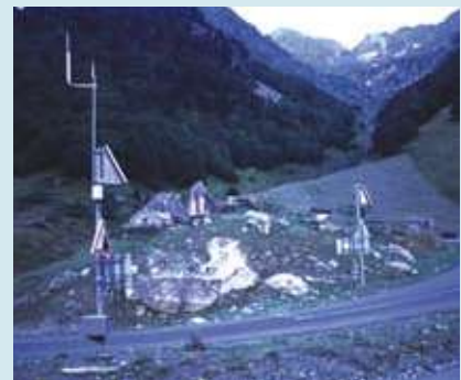
3. Sistema de detecció d'allaus i semàfor a la carretera D-934 del Col du Pourtalet, Pirineu francès, complementat amb un dic deflector que concentra l'afectació en un sol tram de la carretera.
