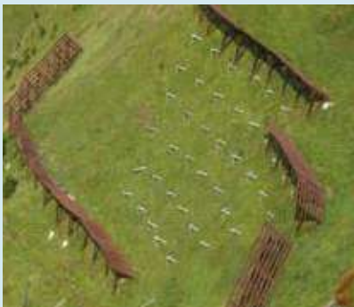
3. Estructures de rugositat tipus trípede intercalades entre barreres de retenció a Wengen, Oberland bernès, Alps suïssos.
