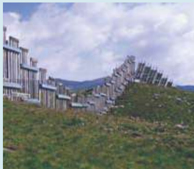
4. Barreres de vent per al dipòsit controlat de la neu al port d'Envalira, Pirineu andorrà.
