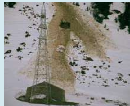
3. Tascó de desviament de protecció d'una torre d'alta tensió a la Bonaigua, Pirineu català. (Foto: IGC.)
