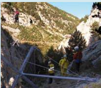
7. Instal·lació de barreres flexibles modulars en una canal amb transport per helicòpter a la Vall de Núria, Pirineu català.
