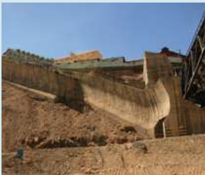
4. Dic deflector i de confinament a Arinsal, Pirineu andorrà. (Foto: IGC.)
