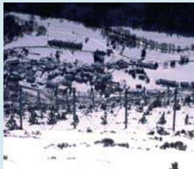
6. Barreres flexibles de xarxa per a la retenció de la neu i per afavorir la reforestació a Porté, Pirineu francès.
