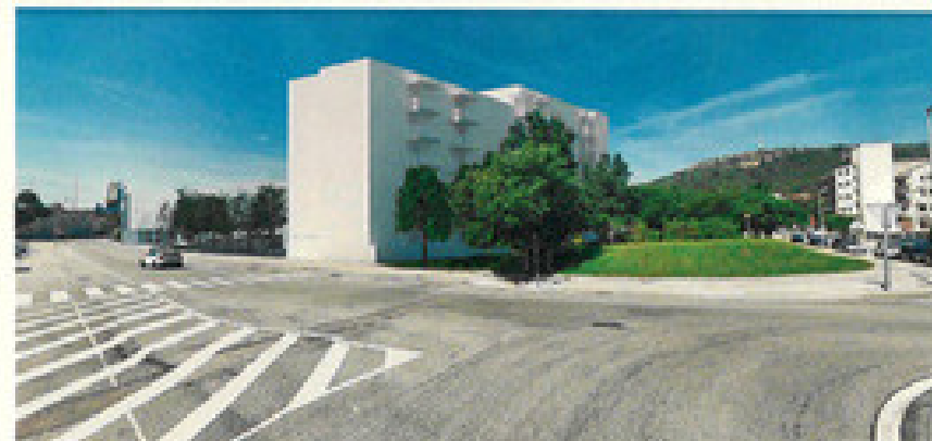
Vista sotana carrer Cervantes amb Ronda de Santa Eulàlia
