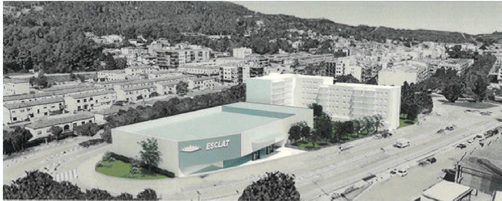
Vista aerea PAU PLL1
