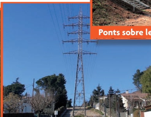
Urbanització de l'avinguda del Baixador.
